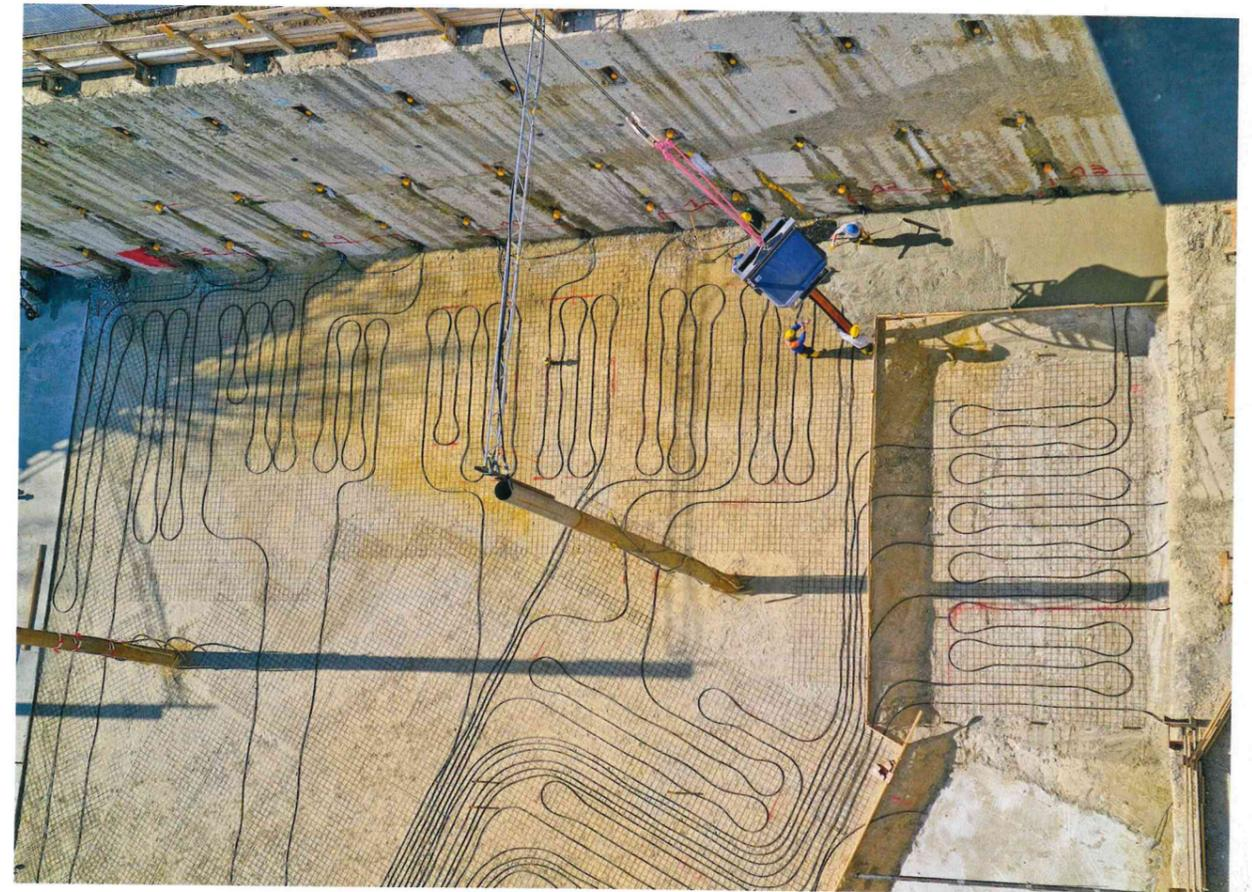
Abb. 11 – Blick in die Baugrube: Vorbereitung der geothermischen Aktivierung, hier mit dem Auslass der Geothermie-Rohre aus der MIP-Wand unter GOK, auf Höhe der späteren Bodenplatte.
