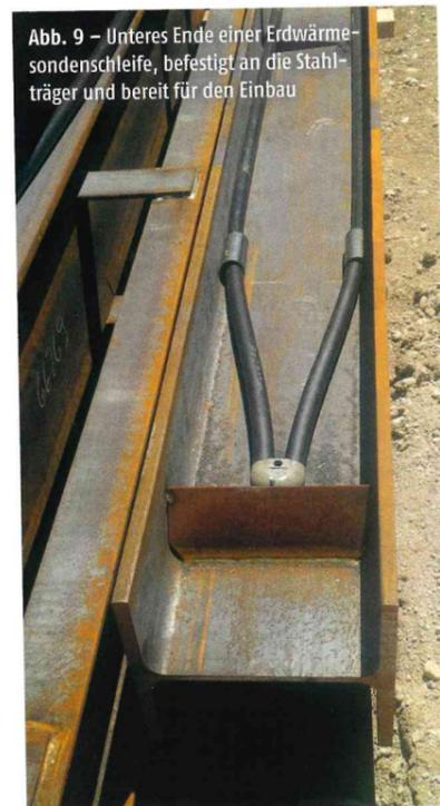
Abb. 9 – Unteres Ende einer Erdwärmesondenschleife, befestigt an die Stahlträger und bereit für den Einbau
