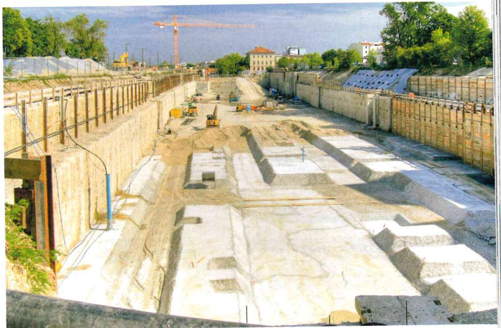
Abb. 2 – Eine typische, durch eine MIP-Wand gesicherte Baugrube in München
